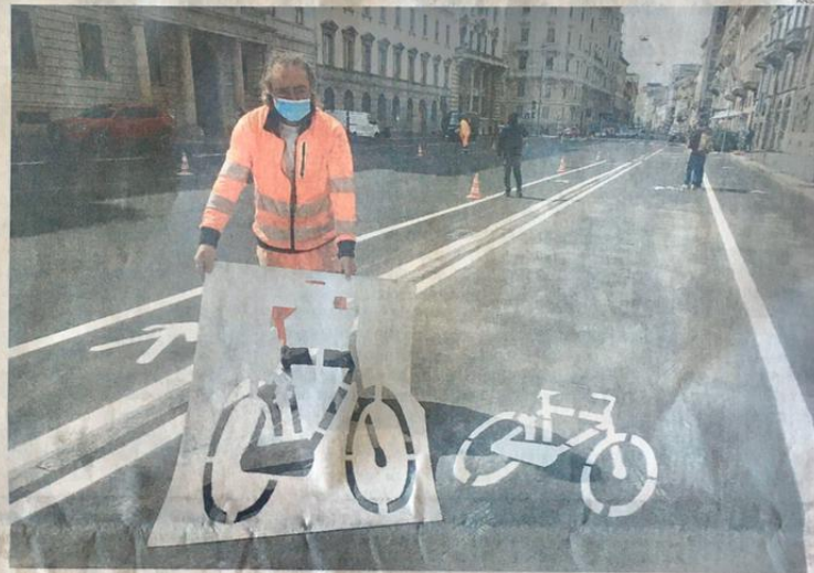
A Milano. Un operaio al lavoro in Corso Venezia per creare nuovi spazi riservati a ciclisti e pedoni lungo la M1
