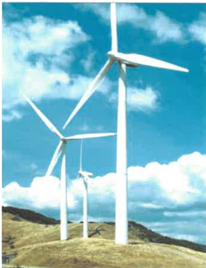
▲ Gli impianti convertitori eolici a Varese Ligure (La Spezia)
