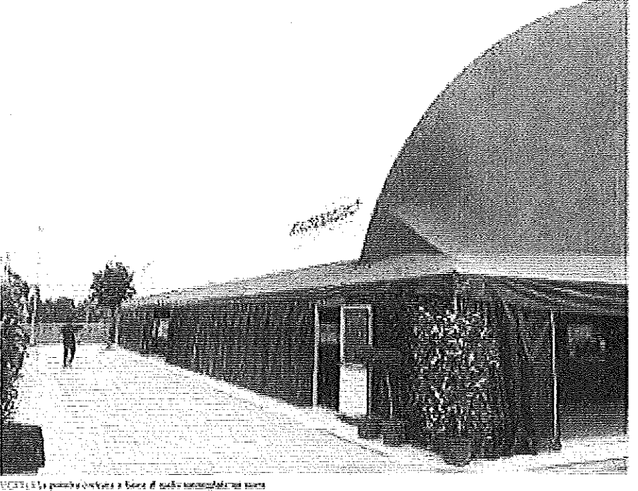
Il nuovo palasport di Medolla, in corso di costruzione.
